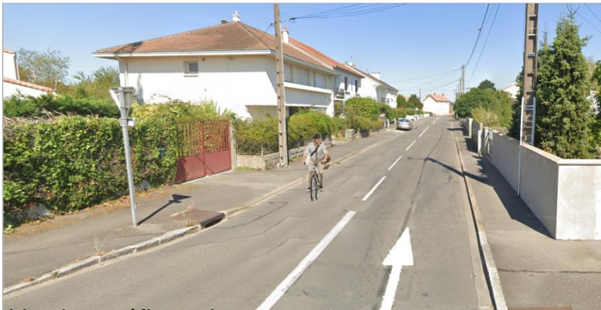
Version préfiguration : Travaux de marquage et de signalisation
