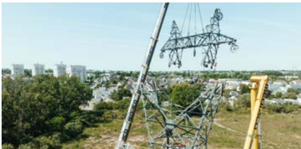
RTE, gestionnaire du réseau de transport d'électricité français, renouvelle le réseau électrique de la métropole de Nantes. Après la construction d'une liaison électrique souterraine en 2025, la ligne aérienne à 90 000 volts, longue de 6,9 km, va être retirée. Cette ligne relie le poste électrique du Lion d'Or à Nantes jusqu'au poste du Praud à Divatte-sur-Loire, en passant par Saint-Sébastien. **Les travaux vont démarrer en août 2025.**
